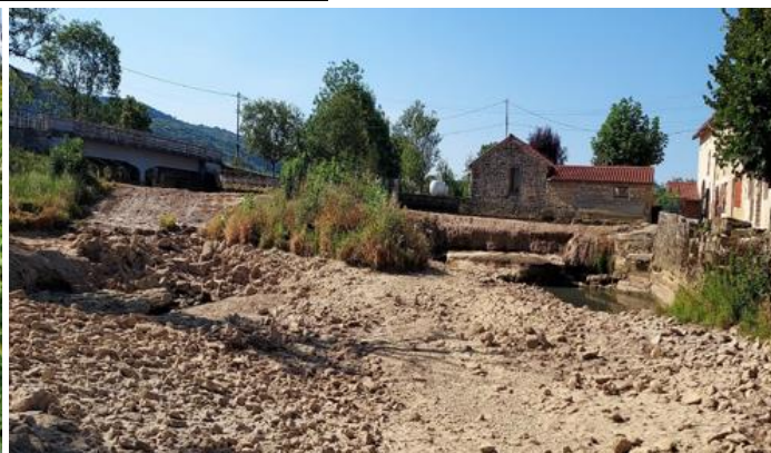
Aval de la chaussée : rivière à sec
